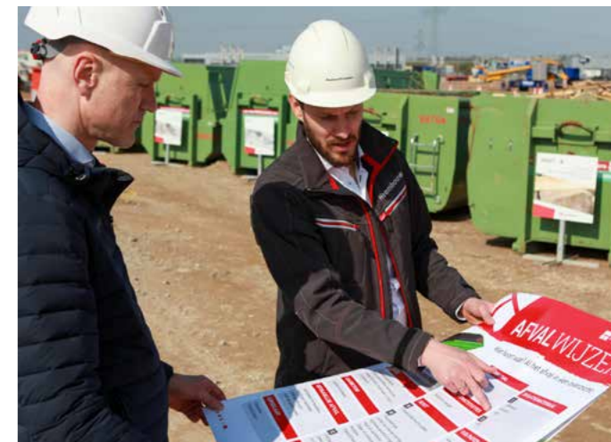
Afvalscheiding op de bouwplaats.
