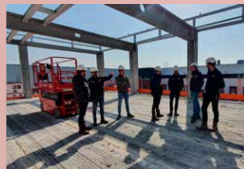
Rondleiding op de bouw. #BOUWPLAATSBEZOEK
