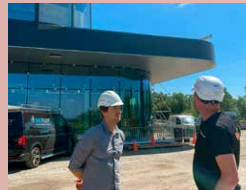
Bouwplaatsbezoek Brocacef. #MOOIDETAIL
