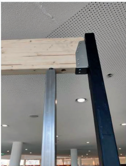
Dit is het gat in de balk waar de stijl in moet komen
