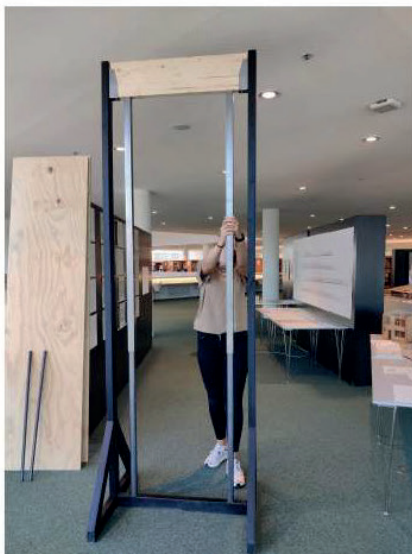
6. Plaats de bovenkant van de stijl in het gat
